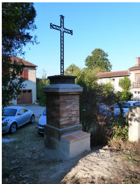
La croix de mission rue Fondeville après sa restauration en 2016
